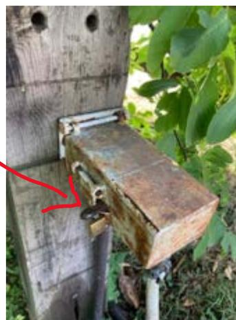
Wichtig ist dabei allerdings, dass das Wasser am anderen Ende des Schlauchs immer auf- bzw. vor allem auch wieder abgesperrt wird (schwarzer Hebel auf der linken Seite). Wird das vergessen, tropft unablässig Wasser aus dem Anschluss, der den Dauerdruck nicht aushält. Bitte achtet darauf !
